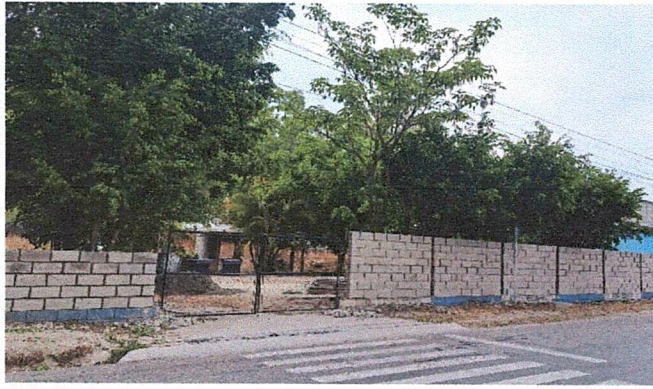
Foto 1: Reparación de muro perimetral.
