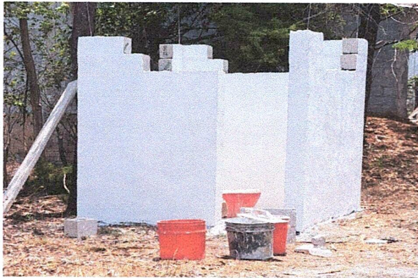
Foto 3: Reparación de baño.
